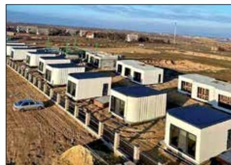
Строительные принтеры уверенно печатают одноэтажные и двухэтажные дома, создавая удивительные архитектурные сооружения. Одноэтажный корпус площадью 35 квадратных метров печатается всего за 2 дня, после чего проводятся отделочные работы. Двухэтажные дома печатают за 8 дней. Такой массовой застройки в мире еще не было. За 8 месяцев было возведено 4000 кв. м жилья. При этом дома строили на одном принтере всего 2 человека!
